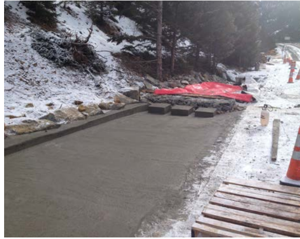
Hoosac Sediment pan concrete pour
